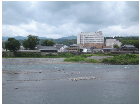
観音院ノ瀬より胸川新町方面を見る 22.6.19
